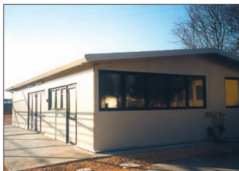
Tra il 2003-2004 viene realizzata la struttura delle cucine
